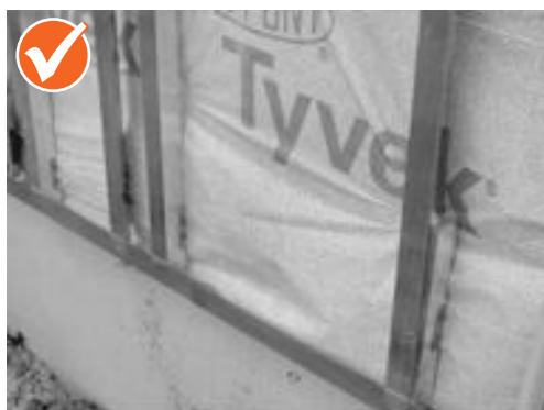
Правильно установленный вертикально L-профиль
